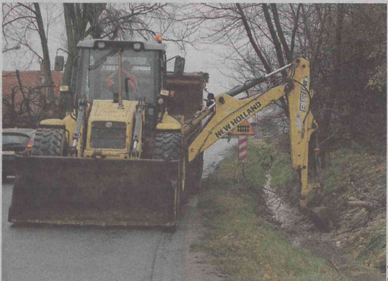
Mieszkańcy Zielonych Ogrodów mogą obserwować te prace
