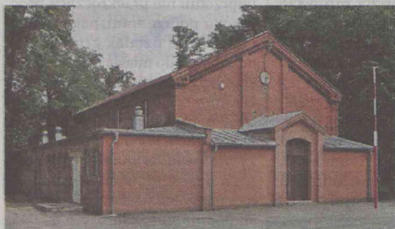
Tak wyglądała kiedyś ceglana elewacja sali
