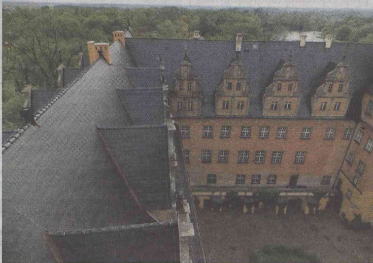
Widać z góry setki metrów kwadratowych nowego dachu
