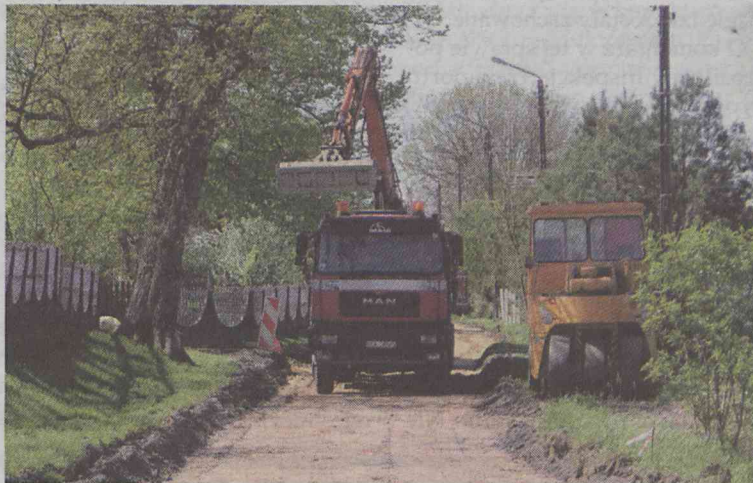
Budowa drogi w Solnikach Wielkich
