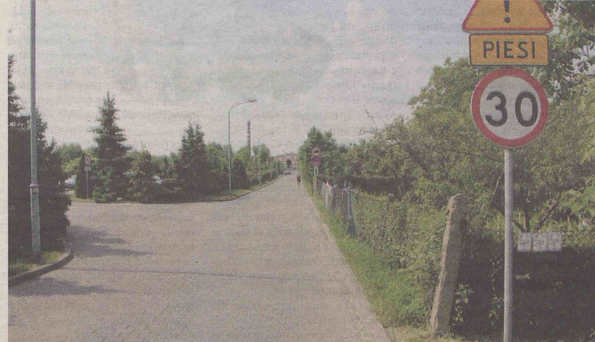
Ulica Limanowskiego zostanie poszerzona, aby skrócić drogę ciężarówkom
