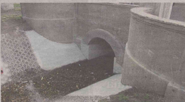
Wyremontowany przepust na rzece Świerzna...
