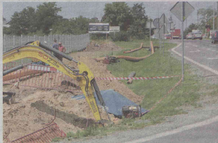
Przy strefie gospodarczej kładziony jest gazociąg
