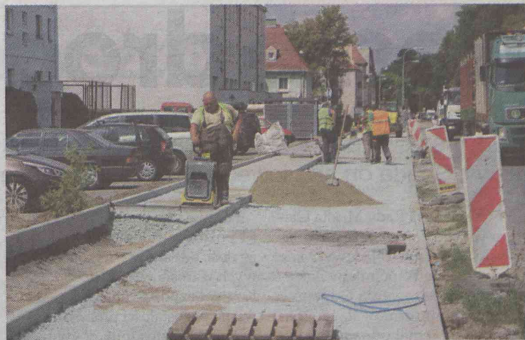
Już wylaniają się chodnik i ścieżka na Krzywoustego
