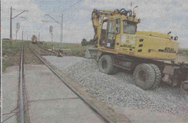
W Bierutowie remontują przejazd
