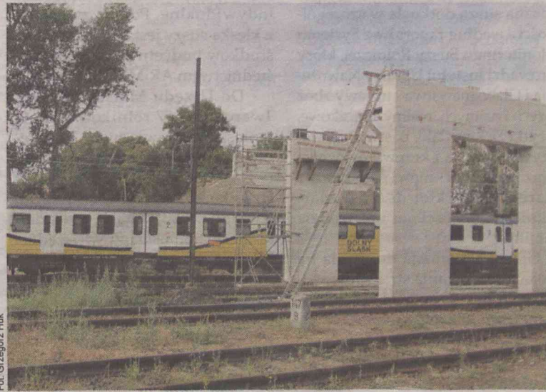
Filary gotowe, czas na montaż prześel
