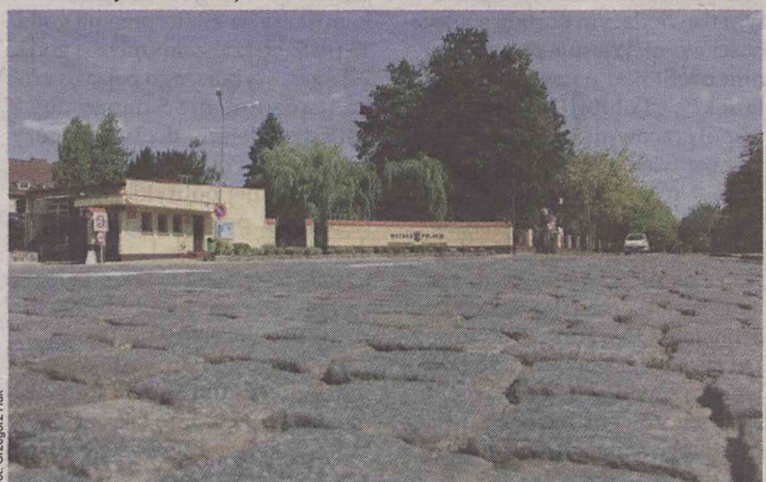
To ostatnia zabytkowa nawierzchnia drogi w Oleśnicy
