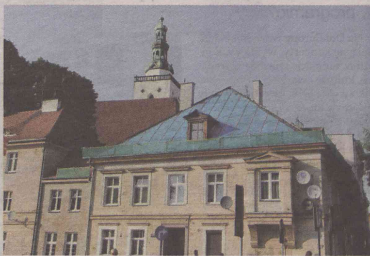
Na razie robi się dach
