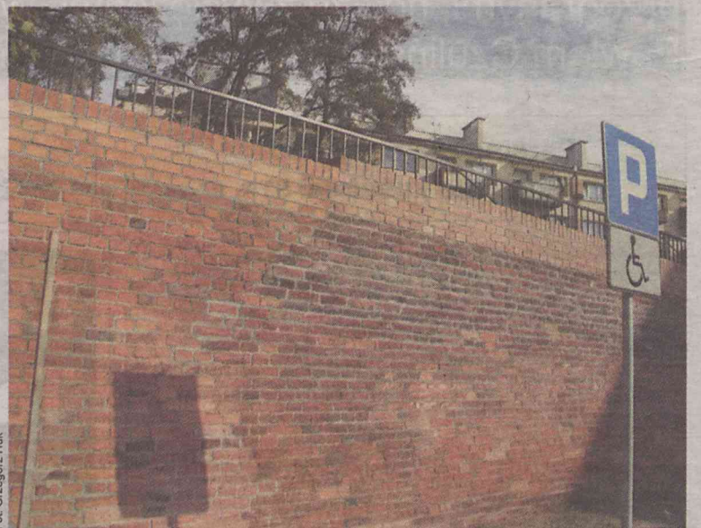
Wyremontowany mur przetrwa kolejne stulecia
