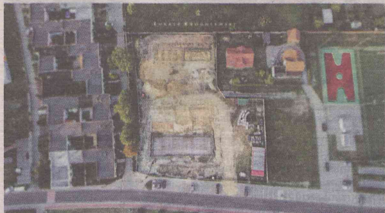
Właśnie trwa budowa
