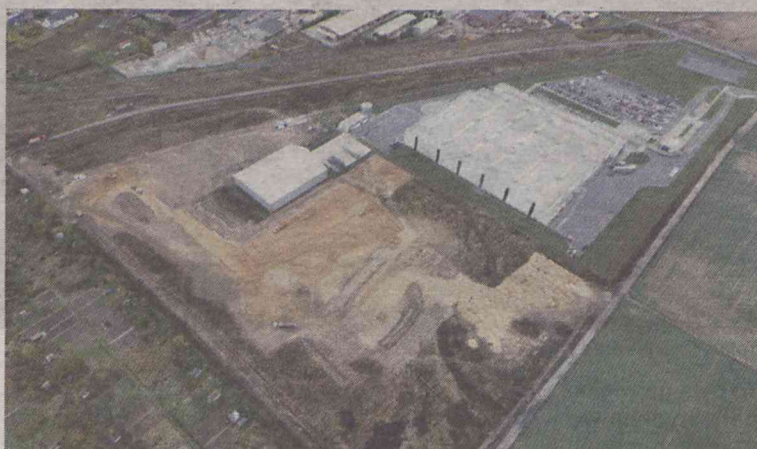
Rozbudowa idzie pełną parą
