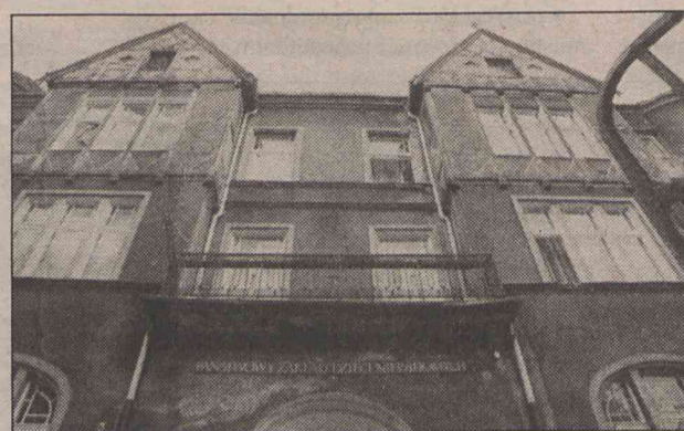
Budynek Państwowego Zakładu Dzieci Niewidomych przy Al. Kasztanowej we Wrocławiu
