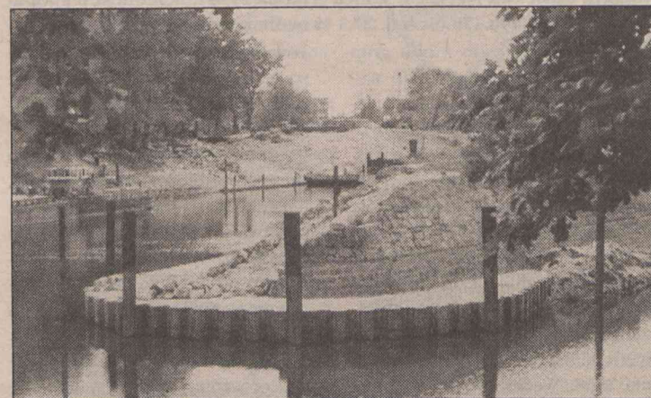
Jaz Szczytniki podczas remontu
