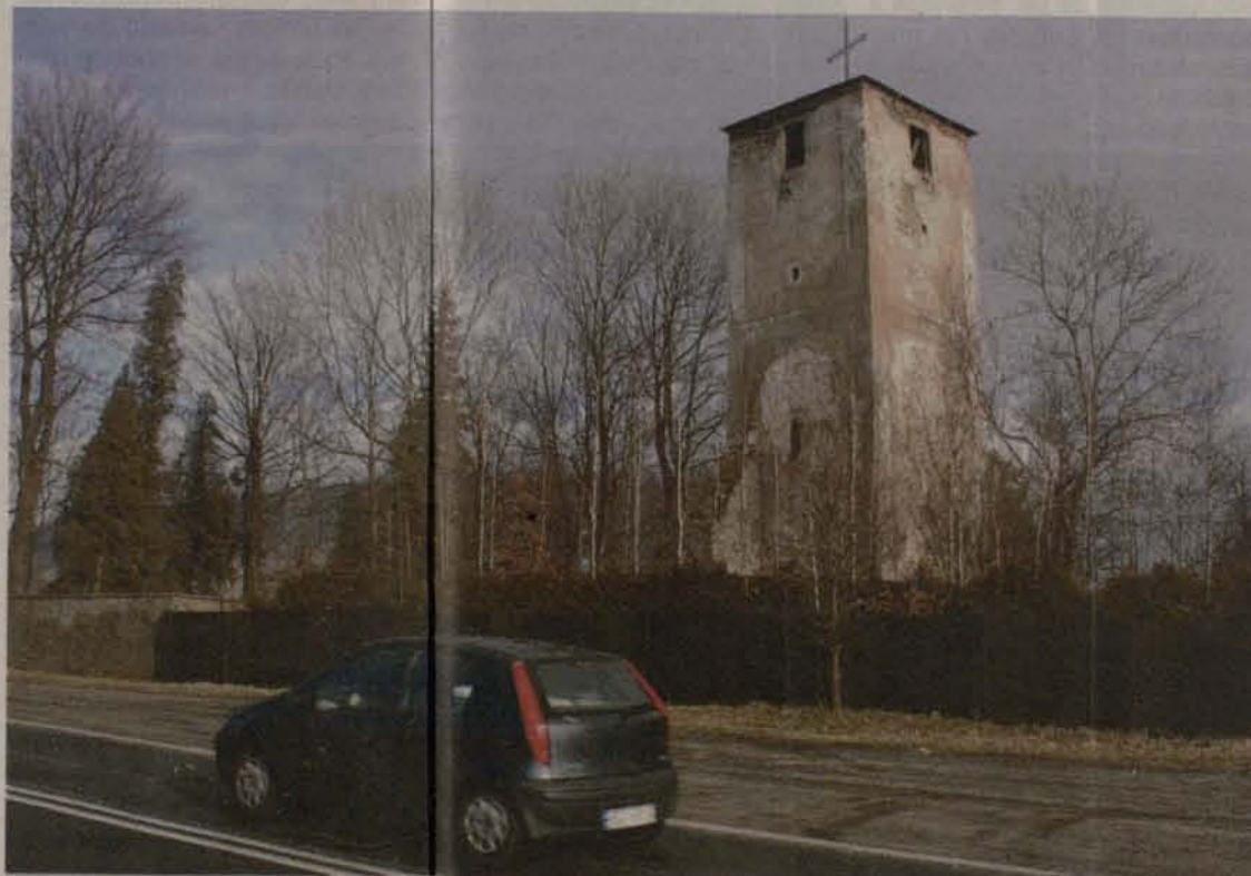
Wieża w Radomierzu stoi tuż przy drodze z Jeleniej Góry w kierunku Bolkowa i Wrocławia.
