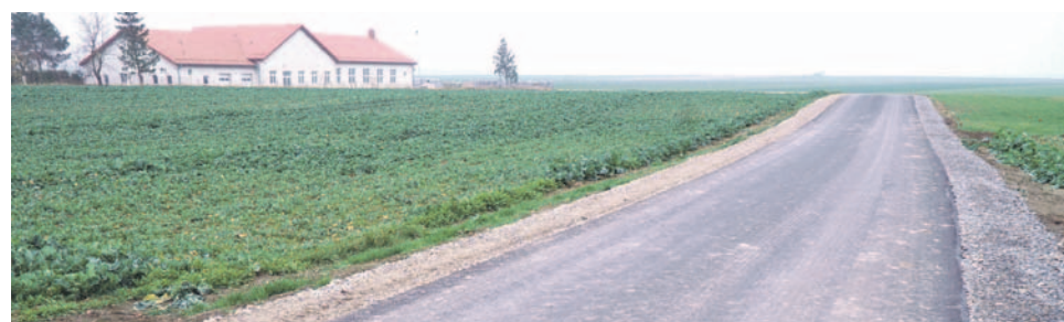
Wyremontowana droga stanowi także dojazd do świetlicy w Chwalibóżycach.
