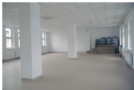
Zakres prac obejmował prace budowlane zarówno w środku budynku, jak i na zewnątrz.
