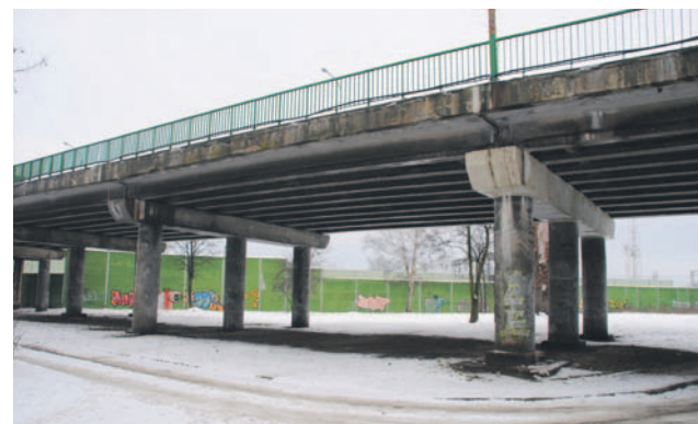
Ważną oławską inwestycją w roku 1974 było oddanie do użytku wiaduktu nad torami kolejowymi
