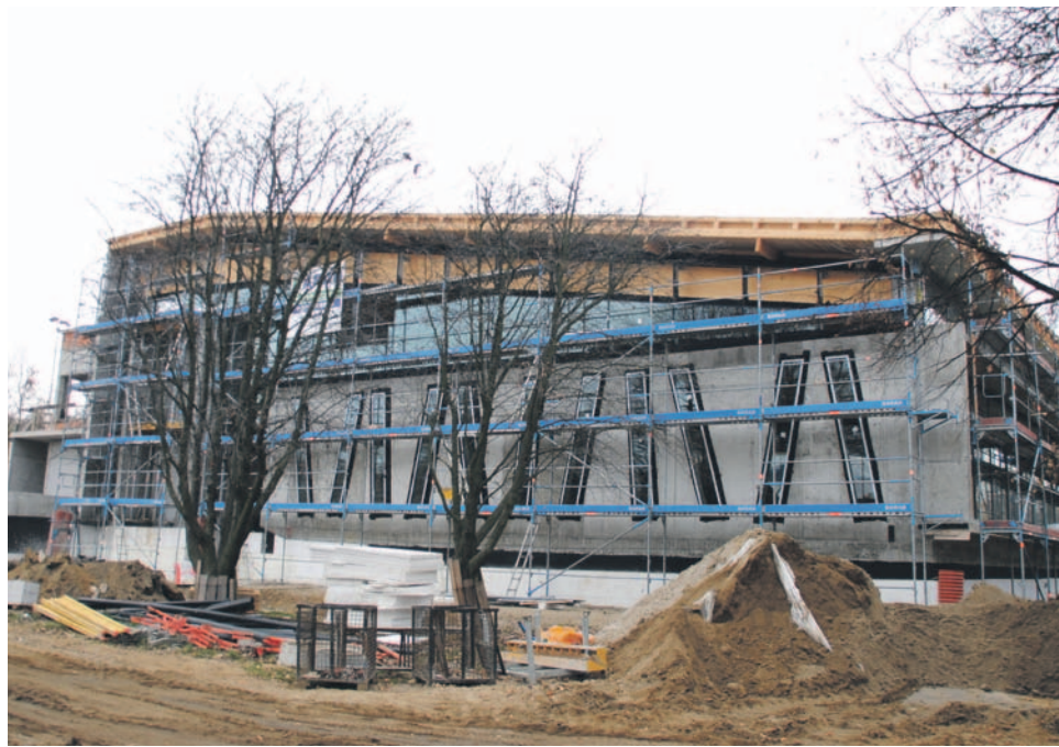
Termy Jakuba w budowie
