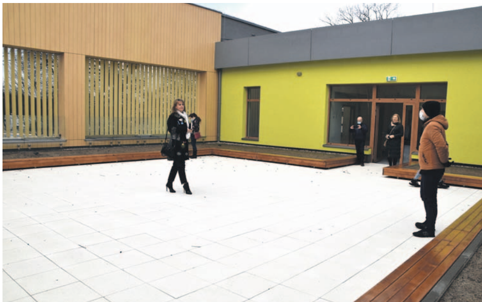
Innowacyjnym rozwiązaniem jest zewnętrzny taras do zabawy dla dzieci, znajdujący się na dachu budynku, czeka na wyposażenie
