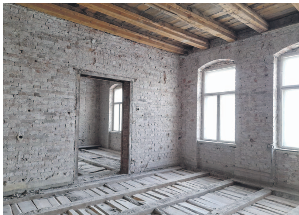
Prace prowadzone są pod nadzorem konserwatora zabytków
