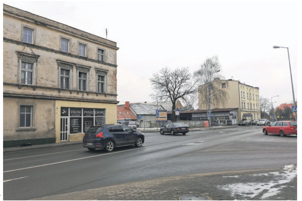
Budynek widoczny po lewej będzie wyburzony
