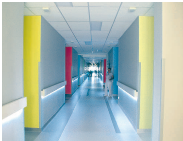
W 2019 roku wyremontowano oddział chirurgiczny olawskiego szpitala. Teraz niezbędny jest remont oddziału wewnętrznego, który jest w bardzo złym stanie
