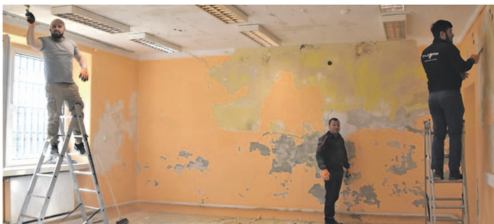
Prace idą pełną parą
