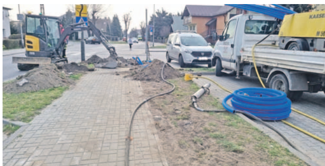
Rozpoczęły się roboty przy modernizacji drogi na ul. Zacisnej
