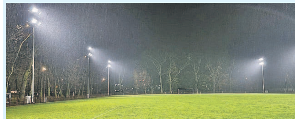
Nowe oświetlenie drugiego boiska treningowego na Stadionie Miejskim
