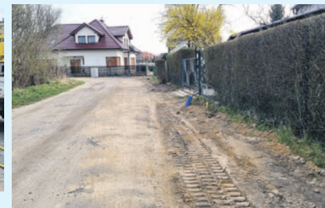
Trwają prace budowlane na części ulicy Okólnej
