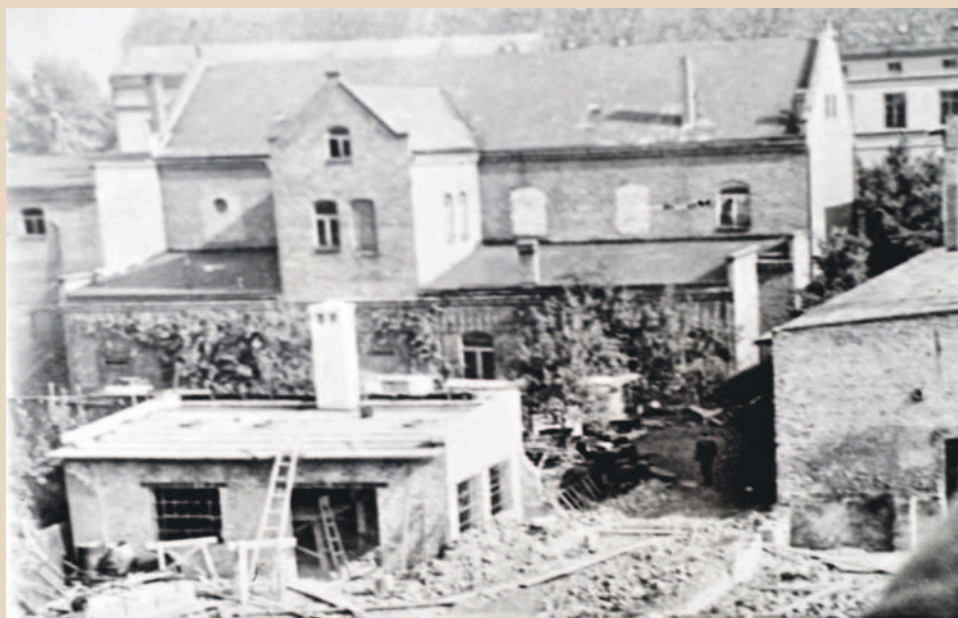
Na zdjęciu plac, na którym były Zakłady Mechaniczne przy ulicy Młyńskiej. Największy budynek to Kino Odra od podwórka. Zdjęcie zrobiono w 1954 roku - dziś to miejsce wygląda całkowicie inaczej, daszki z lewej i prawej nie istnieją, a budynek podniesiony jest wyżej. Po prawej w głębi widzimy budynek koszar. Na pierwszym planie kuźnia w budowie, po prawej była stolarnia, do której pod koniec lat 50. dobudowano halę produkcyjną, gdzie lakiernicy szpachlowali, szlifowali i lakierowali gotowe wyroby
