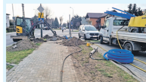
Trwa modernizacja ul. Zaciszej. Inwestycja realizowana przez Starostwo Powiatowe oraz Urząd Miejski w Oławie
