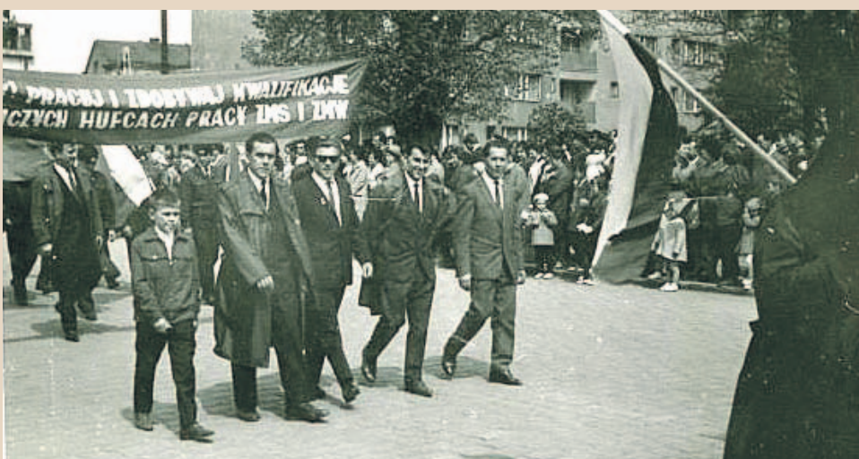
Zdjęcie z albumu Krystyny i Henryka Piotrowskich (1961) - widzimy grupę pracowników Gminnej Spółdzielni. W głębi po prawej nowo wybudowany budynek mieszkalny przy ul. Przyjaciół Żołnierza Polskiego 4-12
