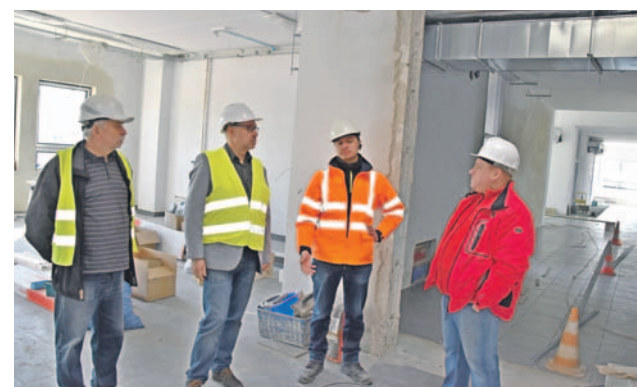
Kierownik budowy Wojciech Żymańczyk (drugi z prawej) omawia postępy prac
