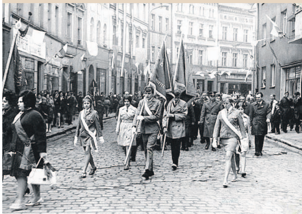
Zdjęcie z albumu Ryszarda Gawrona (1970). Na ulicy Brzeskiej uczestnicy pochodu, na czele poczet sztandarowy Związku Harcerstwa Polskiego. Proszę zwrócić uwagę, jak nierówna była nawierzchnia z kostki brukowej po wykonaniu prac ziemnych przy montażu instalacji
