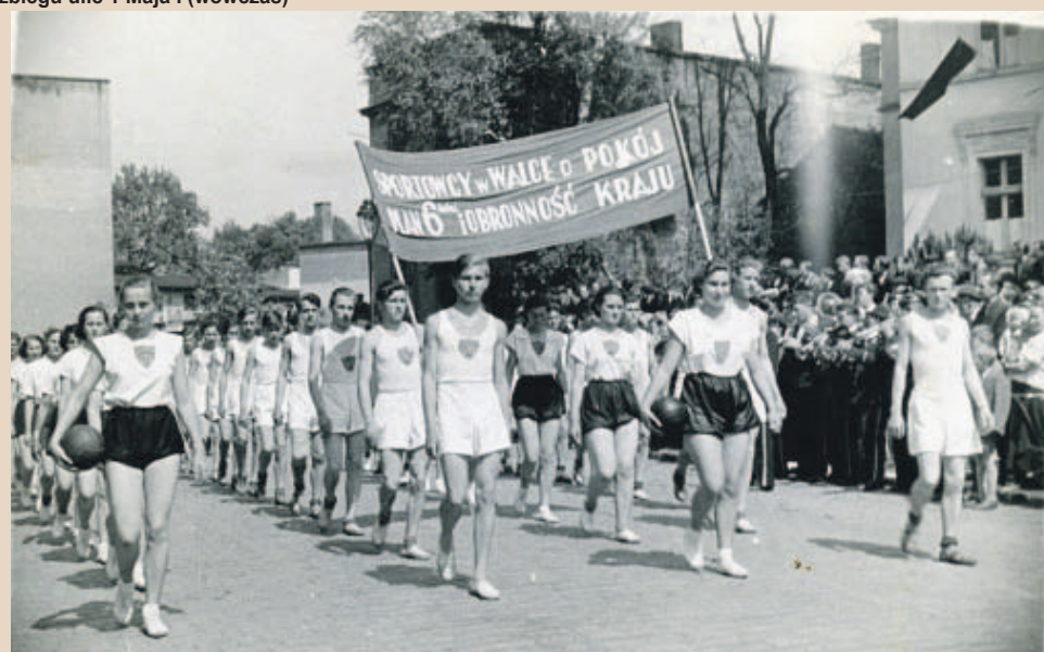
Zdjęcie z albumu Renaty Luch (1956) - maszerują młodzi sportowcy. W głębi po lewej budynek mieszkalny ze sklepem spożywczym na parterze, w środku w głębi kawałek stacji paliwowej CPN. Za transparentem widzimy budynek mieszkalny, a po prawej część budynku, gdzie mieścił się żłobek
