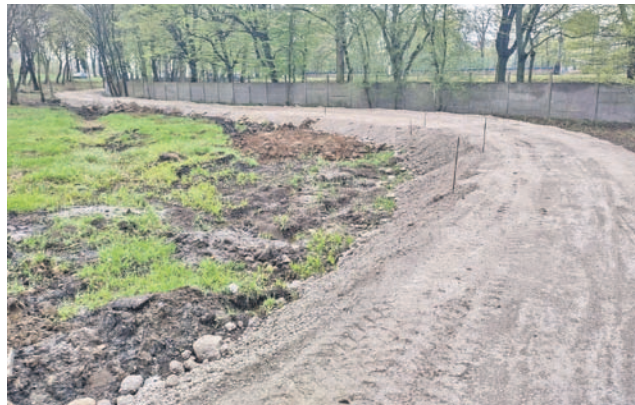
Fragment budowanej ścieżki rowerowej w pobliżu stadionu
