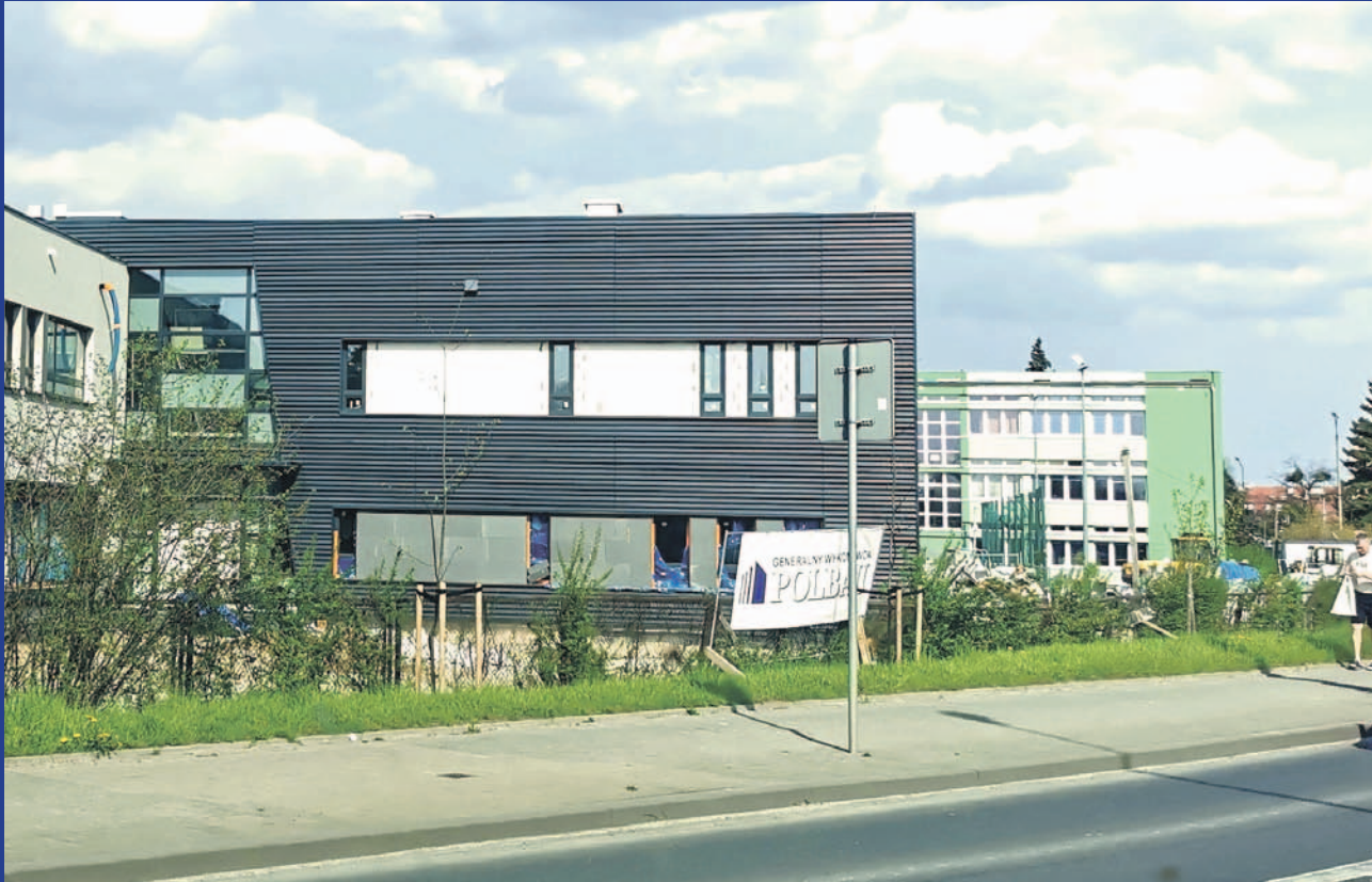
Budowa nowoczesnych warsztatów przy szkole na ul. Kutrowskiego jest już na ukończeniu. Miejsce trzeba będzie jeszcze wyposażać, a to koszt ponad 5 mln złotych. Powiat złożył wniosek do rządowego funduszu Polski Ład
