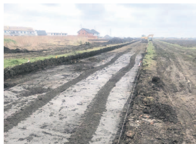
Rozpoczęcie budowy tzw. drogi średnicowej
