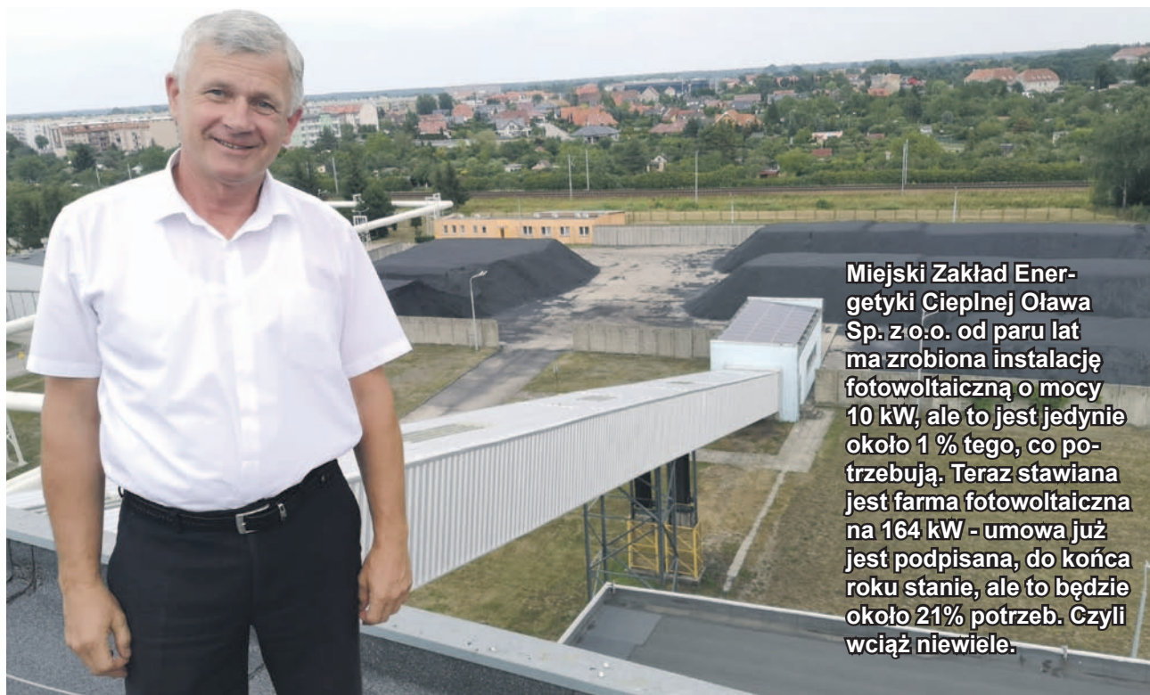
- Opału na ten sezon grzewczy na pewno nam wystarczy - zapewnia prezes zarządu Miejskiego Zakładu Energetyki Ciepłej - Oława Sp. z o.o. Marek Gmiterek. I pokazuje hałdy zgradowanego opału węglowego
