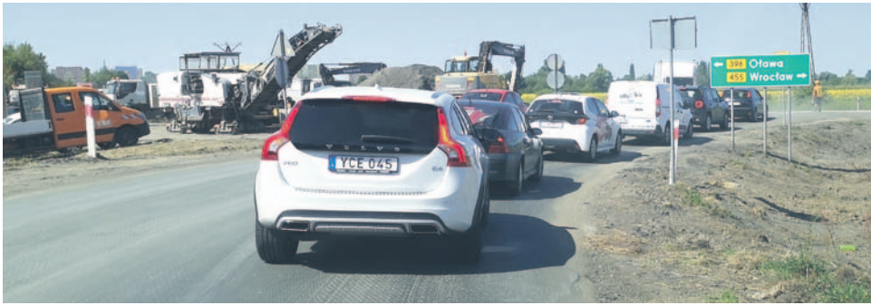
Remont na tym skrzyżowaniu powinien potrwać do końca lipca
