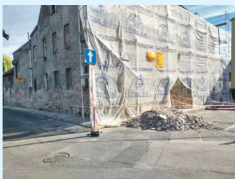
Rozpoczęła się modernizacja budynku oraz remont zabytkowego muru przy Placu Piastów. Dodatkowo wykonany zostanie mural nawiązujący do XVIII-wiecznych rycin Oławy Friedricha Bernharda Wernera. Autorem koncepcji muralu jest oławski artysta Kamil Tobiasz. Prace są wykonywane pod ścisłym nadzorem Wojewódzkiego Konserwatora Zabytków
