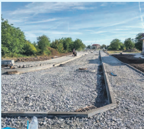
Trwa budowa drogi na ulicy Serdecznej (na fot). Podobne prace prowadzone są na ulicy Rodakowskiego, Połudnowej, Okólnej i Dąbrowskiego
