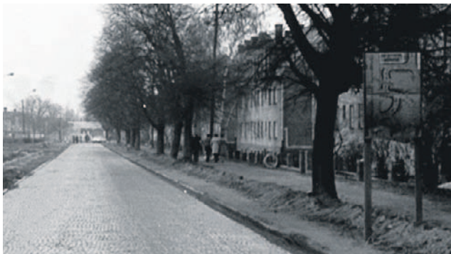
1971. Ulica Opolska. Po prawej lewej znak drogowy informujący o objeździe w prawo na ulicę Dąbrowskiego i Małodworcową, w związku z budową wiaduktu
