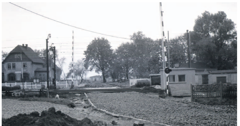
1971 - budowa przejazdu na czas budowy wiaduktu pomiędzy ulicą Różaną a Małodworcową. W głębi po lewej budynek dworca kolejowego linii Oława - Boreczek. Dziś w tym budynku po przebudowie są mieszkania
