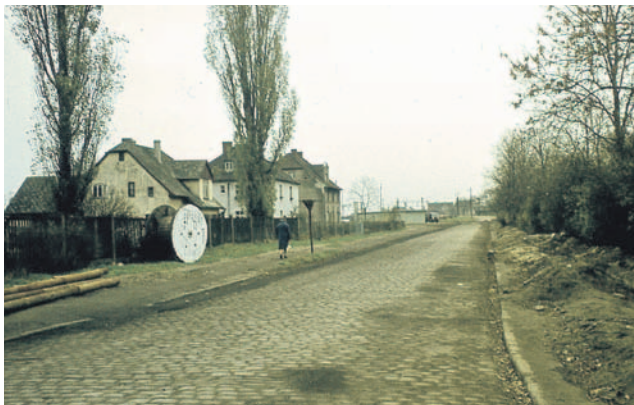
1972. Ulica Różana - na końcu był przejazd kolejowy, wybudowany na czas budowy wiaduktu. Na kostce brukowej położono dywanik asfaltowy, chodniki nadal były „ziemne”
