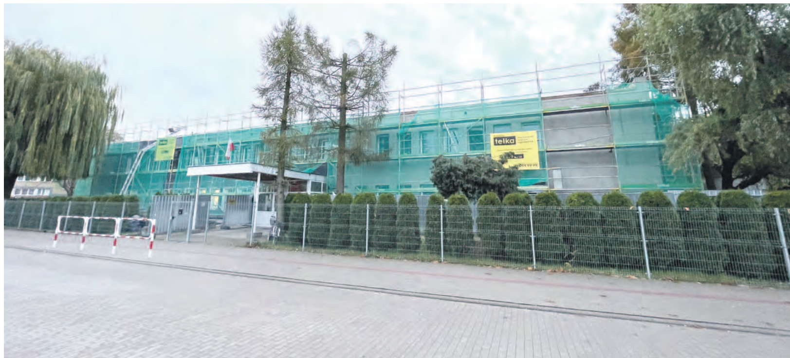
W Przedszkolu Publicznym nr 2 trwa remont
