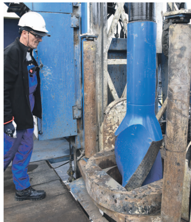
Prace przy wykonaniu próbnego odwiertu ruszyły 4 listopada.
