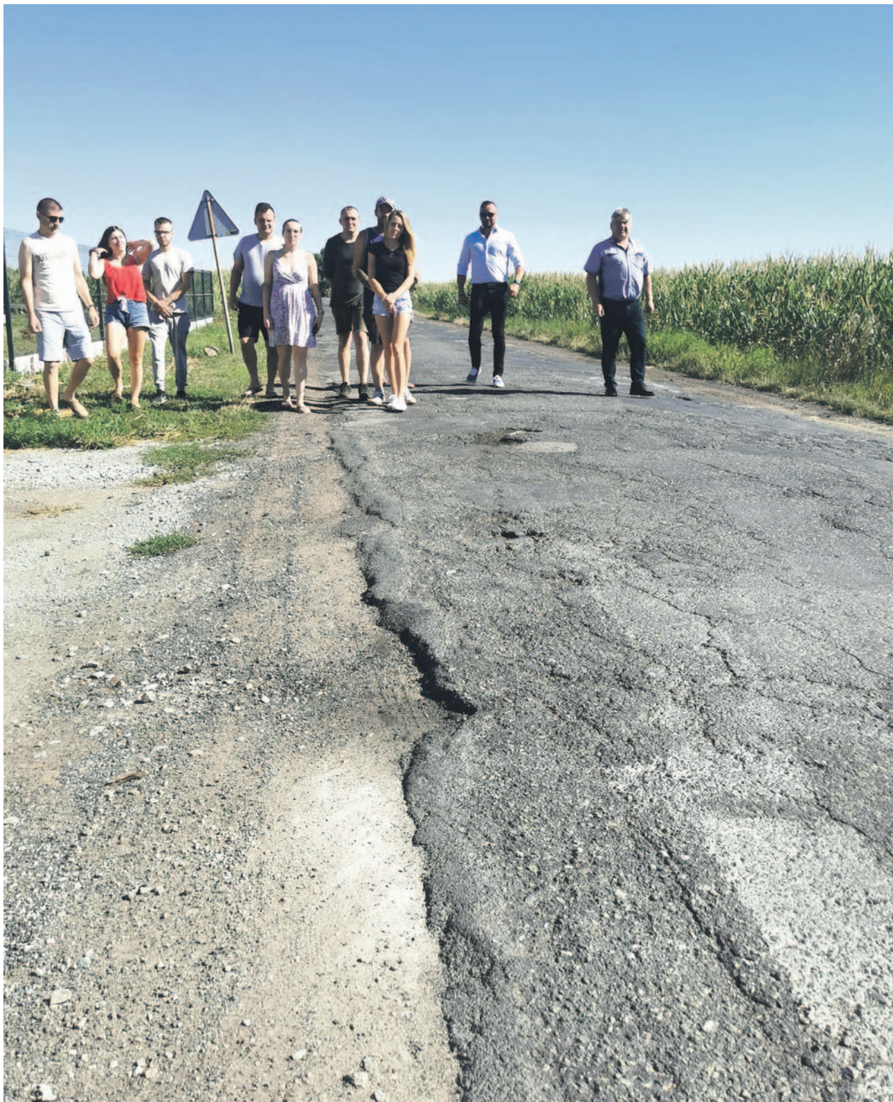
Mieszkańcy Miłonowa w lipcu grozili protestem. Mówili, że powiat o nich zapomniał, a stan drogi woła o pomstę do nieba... Remont ruszył!
