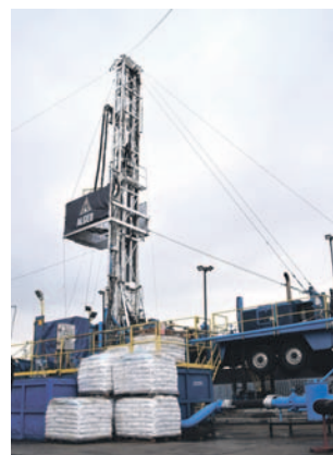
Odwiert jest wykonywany za pomocą takiego urządzenia na terenie Zakładu Energetyki Ciepłej w Oławie
