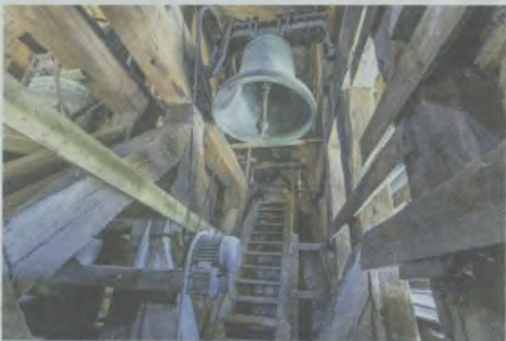
Dzwonnica bazyliki przeszła kompleksowy remont
