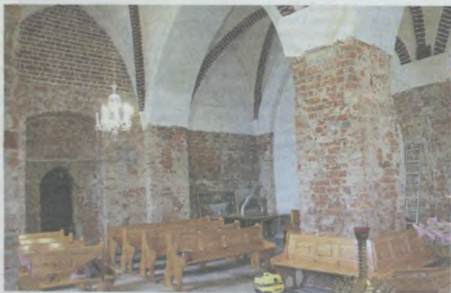
Tak wyglądała świątynia w trakcie remontu
