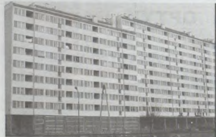
Wieżowiec już zasiedlony! Lokale na dole jeszcze w budowie
