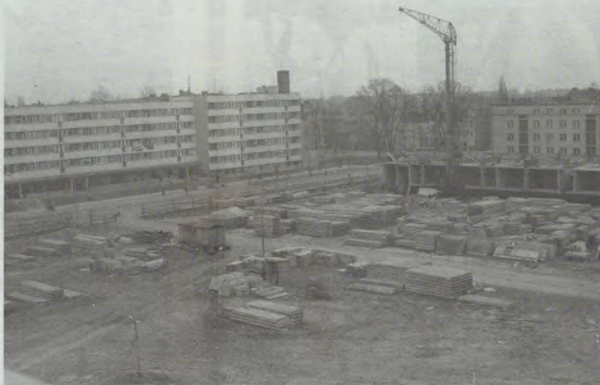
Budowa placu z jednej...
