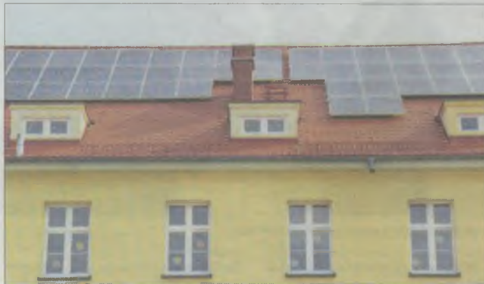
Na dachu szkoły panele już zamontowano
