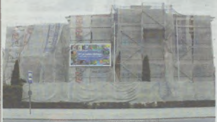
Po remoncie elewacja będzie wrzosowa
