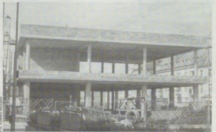
Tak budował się dom handlowy
