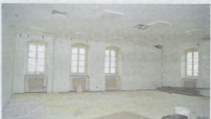
W auli zostały tylko prace kosmetyczne. Będzie tu klimatyzacja
