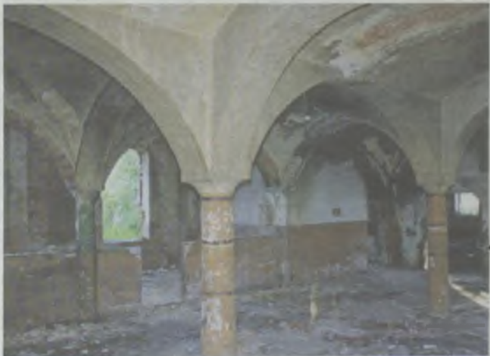
Obiekt jest pod ochroną konserwatorską
