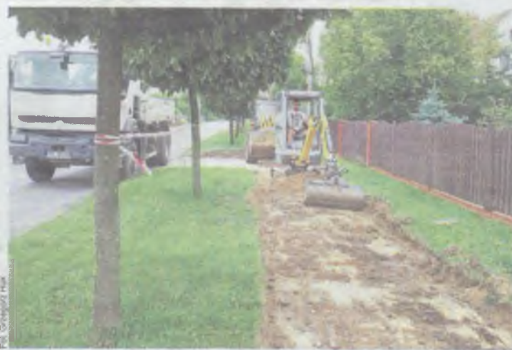
Prace potrwać do końca października
