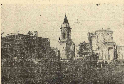
Plac Trzech Krzyży, zlewej strony widoczna budowla gmachu M. S. Przemysłu.
