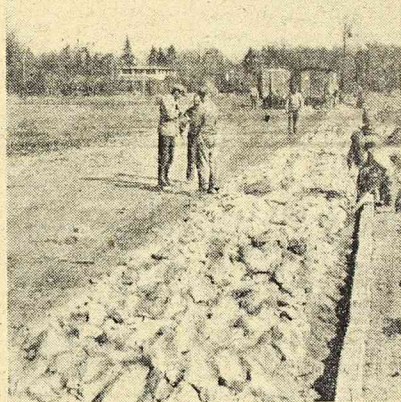
Teren „B” — Zakładanie chodników
