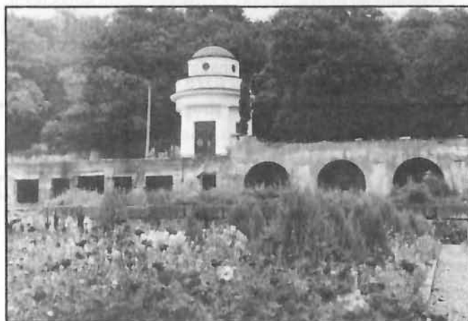
Cmentarz Orląt. Zniszczone katakumby i odbudowana kaplica.
