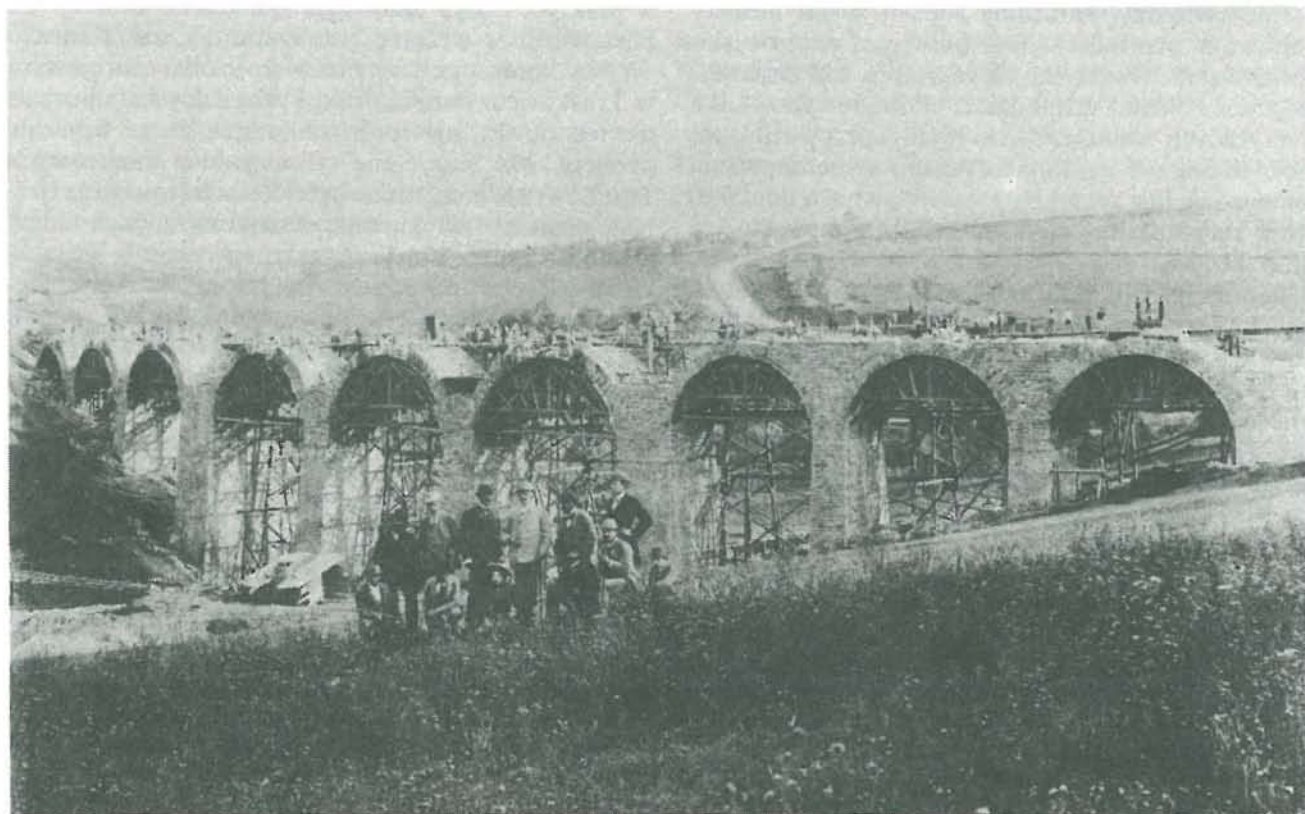
Budowa kamiennego wiaduktu kolejowego
