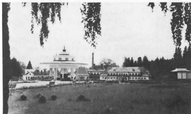
Morszyn. Pijalnia i sanatorium
