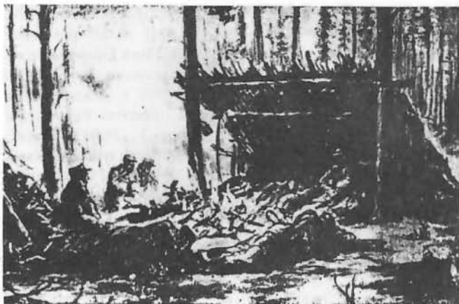
Pierwsza faza budowy obozu. Do czasu wybudowania baraków mieszkalnych więźniowie śpią w skleconych z gałęzi szałasach. „Peczorlag”.
