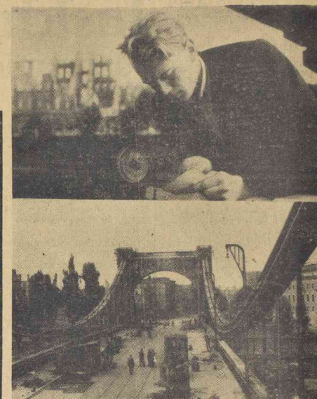
Most Grunwaldzki, ku radości pracowników i całej ludności doskonale wytrzymał przeprowadzoną w dniu wczorajszym próbę obciążenia — o czym obszernie piszemy na str. 4. Na zdjęciu u góry: jeden z inżynierów z napięciem śledzi odchylenia strzałki w czasie próby. U dołu: ostatnie przygotowanie do przeprowadzenia próby.
