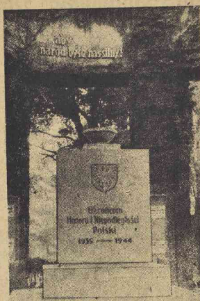
W Zakładowach dokonano w niedziele odsłonięcia pomnika ku czci bohaterów wojny
