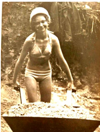
B. Sitek transportuje urobek z wykopu
