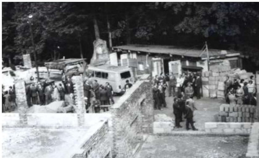
Teren budowy, stan wykonanych prac
