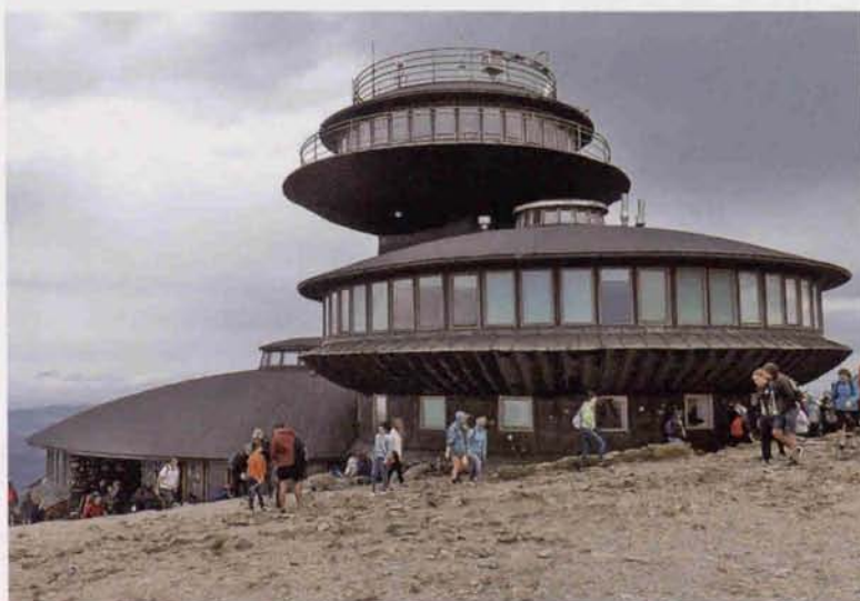
Obserwatorium – stan w 2020 r.
