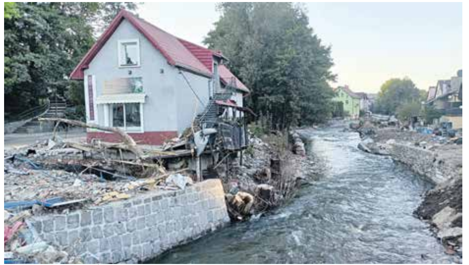
Zniszczenia w Stroniu Śląskim
