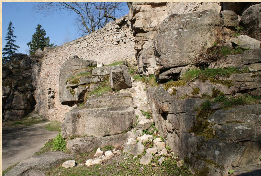
Skalne urwiska w murze
