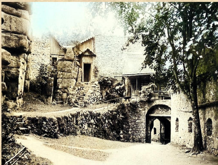
Dobudowane dodatkowe pomieszczenia do ruin zamku
