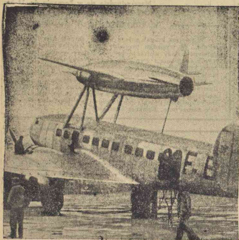
Samolot o napędzie odrzutowym Leduc, umieszczony na grzbiecie czteromotorowej Langueed, który go spuszcza na wysokości 3.000 metrów
