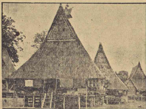
Budownictwo na Sumatrze odznacza się charakterystycznym kształtem przystosowanym do warunków klimatycznych
