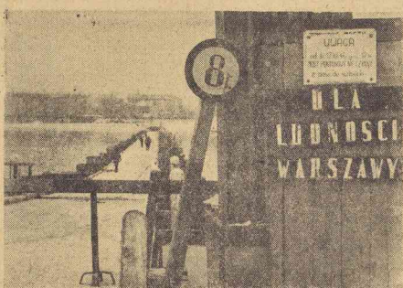
Rozbiórka mostu pontonowego na Wiśle w Warszawie.
