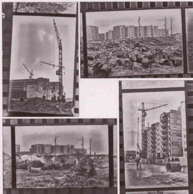
Marek Czeremski „Jak budowano Zabobrze”
