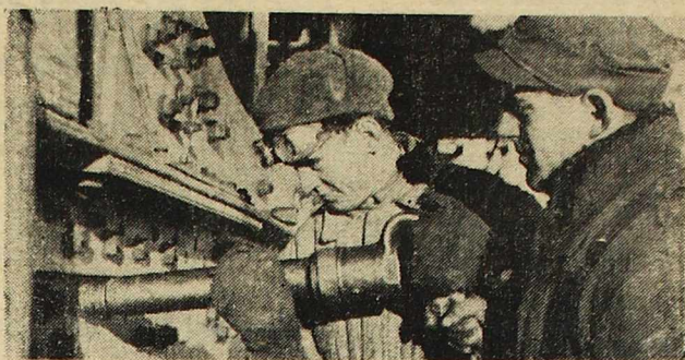
MONTAŻ MOSTU ŚREDNICOWEGO W WARSZAWIE NA UKOŃCZENIU.
