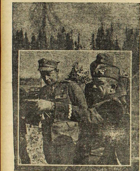
Gen. Świerczewski przeprowadza inspekcję frontu nad Nysą
