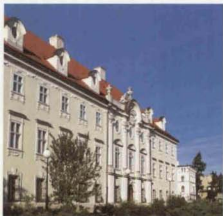
Pałac Schaffgotschów w Jeleniej Górze-Cieplicach.
